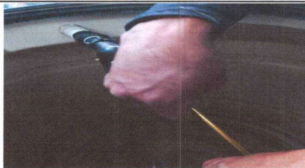
Foto 2: Cambio de accesorios de deposito de agua.
