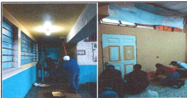
Foto 5: Pintado de aulas y pasillos o corredores.
