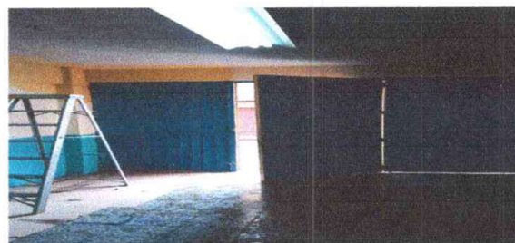
Foto 6: Reparación de Porton de Ingreso al centro educativo
