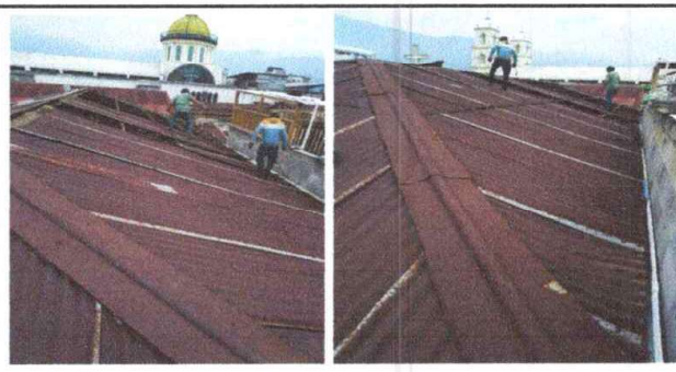
Foto 4: Cambio de techado.
