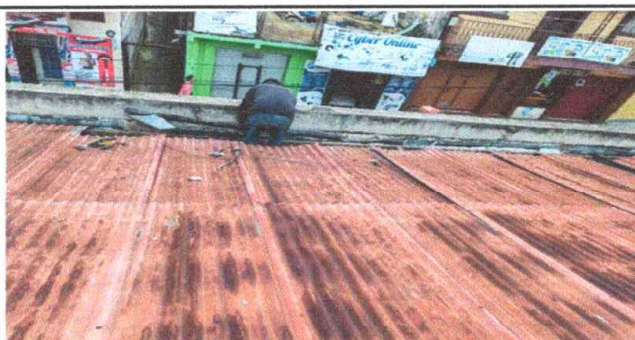
Foto 3: Cambio de canales tanto internos como externos.
